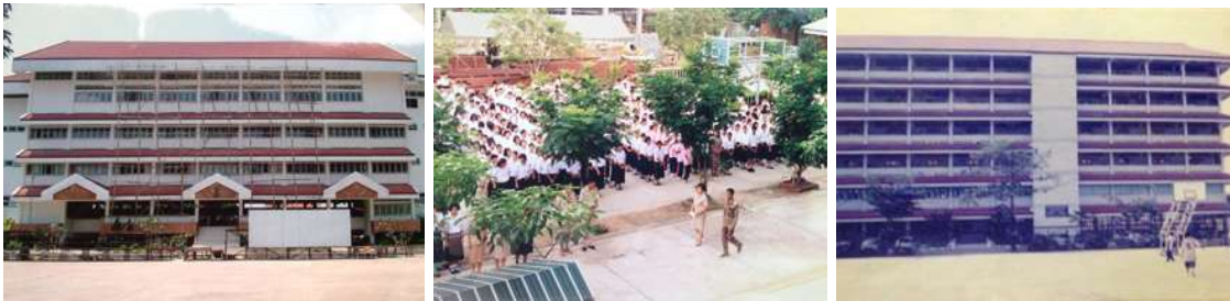
ภาพการก่อสร้างอาคารเรียนที่สองและสามของโรงเรียน
