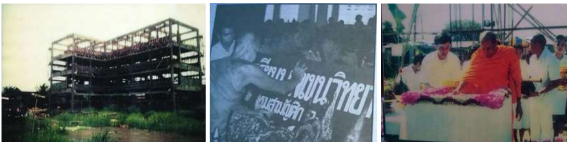
ภาพการก่อสร้างอาคารเรียนแรกของโรงเรียน
