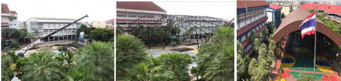
ภาพการก่อสร้างลานโดมอเนกประสงค์สามัคคีภิรมย์ของโรงเรียน
