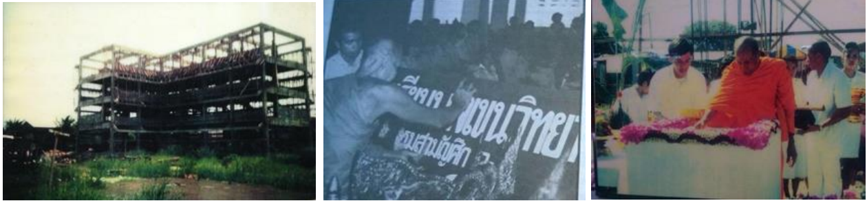
ภาพการก่อสร้างอาคารเรียนแรกของโรงเรียน
